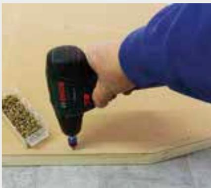
1. Bodenplatten anschrauben
