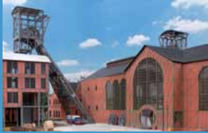
Maschinenhalle und Förderturm
